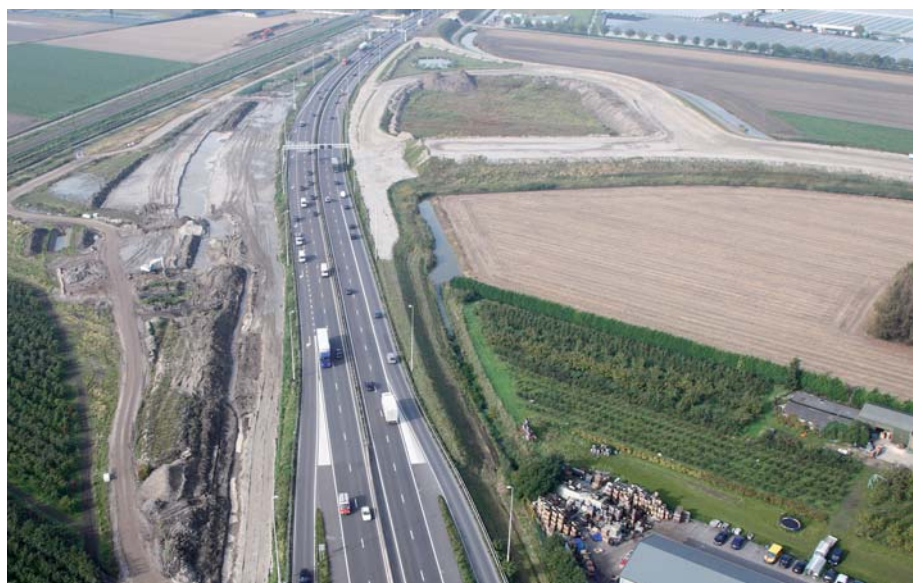
Grondlichamen aansluiting duidelijk zichtbaar
