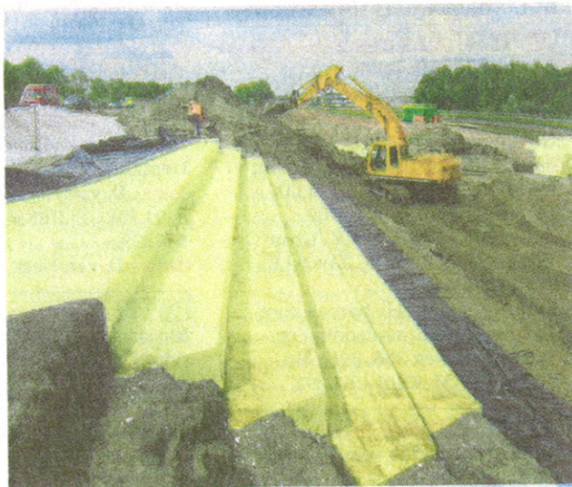
De toepassing van geel eps bij een viaduct in Zaltbommel.
