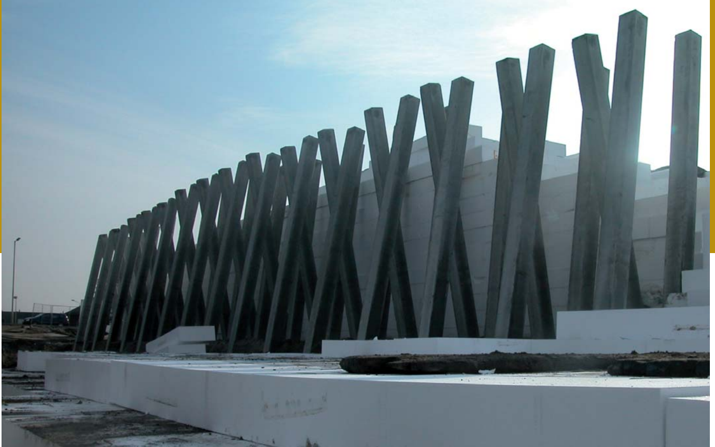
Lichtgewicht ophoging met EPS blokken bij viaduct Bleiswijk
