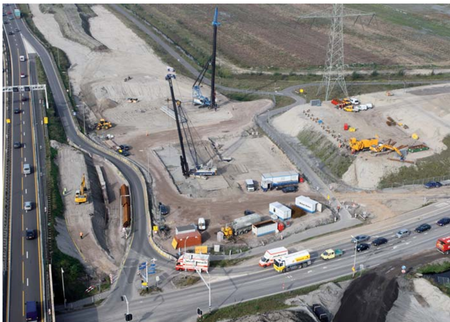
Funderingswerk viaduct Bleiswijk
