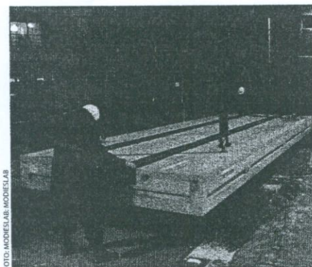
Prefab wegdek met daarin opgenomen rails.
