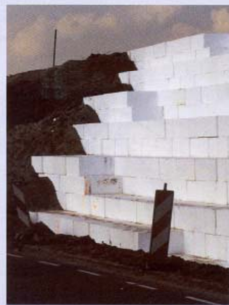
Opbouw van de EPS-blokken bij de westelijke toerit van de kruising.
