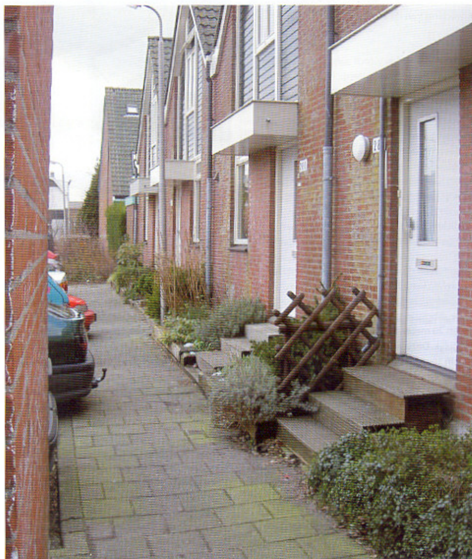
Slappe bodem in Boskoop, voorjaar 2004: tien jaar eerder waren er geen trappetjes en was het straatniveau gelijk aan de drempelhoogte.
