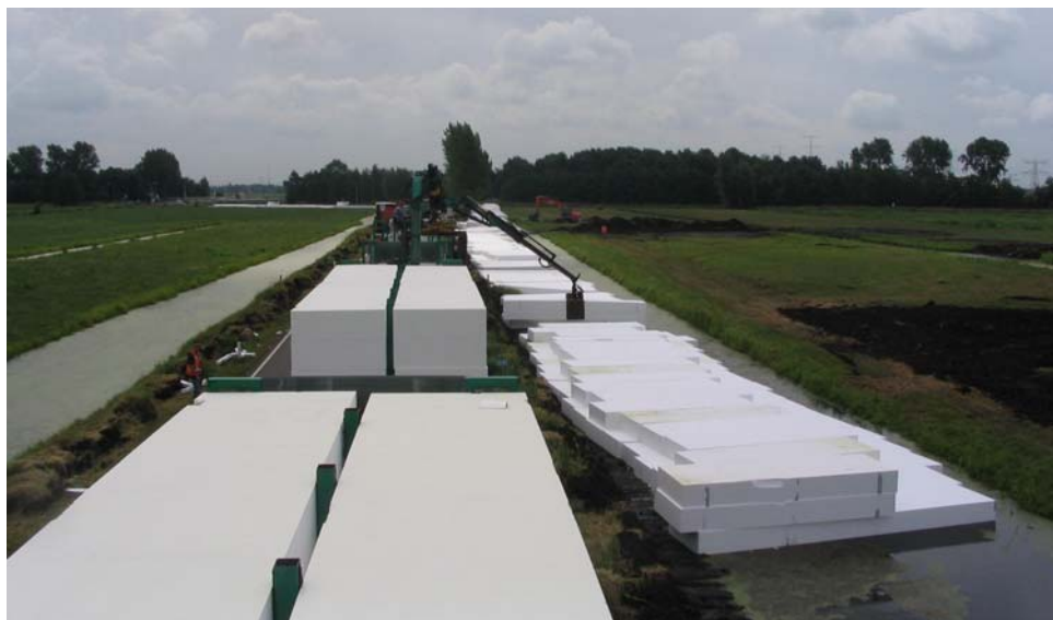
Fig. 8.3 - Werk in uitvoering tijdens de reconstructie van de N475 – Zijdedeg met in de sloten de tijdelijk opgestapelde EPS-blokken
