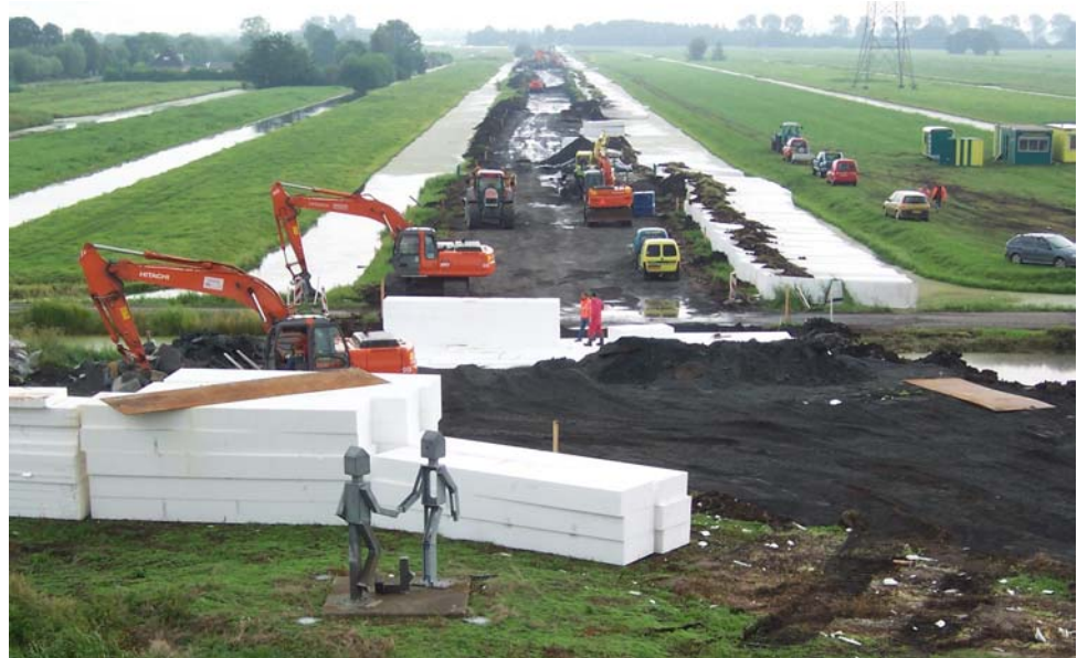
Figuur 8.1 - Werk in uitvoering tijdens de reconstructie van de N475 – Zijdedweg
