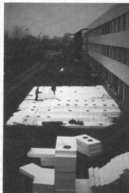
Figuur 3. Doorsnede over een zettingsvrije wegconstructie op polystyreen in een veengebied
