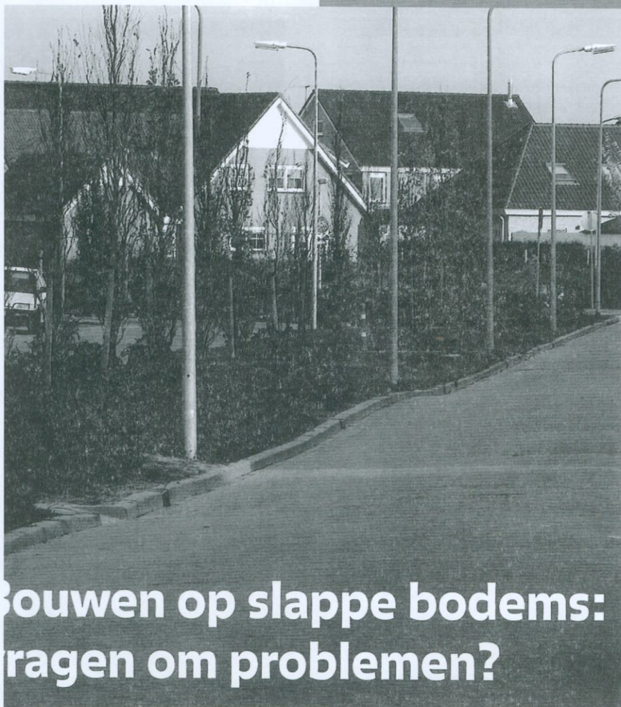
Figuur 1 Golvende wegen ontstaan door verschilzettingen of door een gebroken rioleringsstelsel. Alle foto's: Deltares
