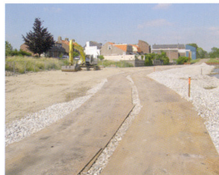
Toepassing van lichte ophoogmaterialen bij dijk in Sliedrecht vanwege belasting op woningen.
