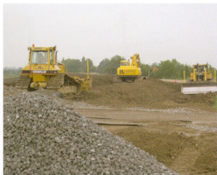
Dijkversterking in Zederik met Granulight (E-bodemas) als alternatief voor oorspronkelijk Flugsand.
