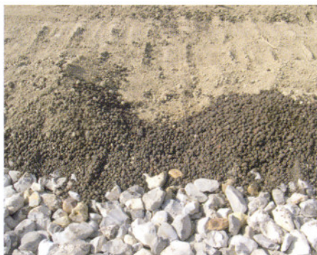
Toepassing van lichte ophoogmaterialen bij dijk in Sliedrecht vanwege belasting op woningen.
